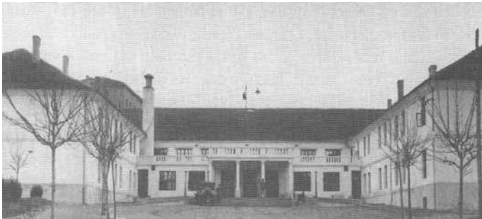
Слика 1. Велика касарна; (извор: Несторовић, Б. Архитектура Србије у XIX веку , Београд)
